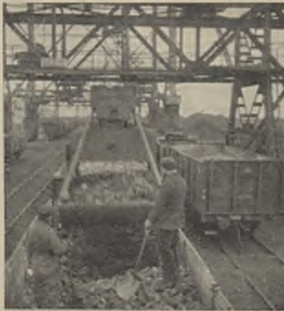
(13) Wyładunek węgla z wagonu na statek przy pomocy dźwigu portowego z chwytakiem w chwili zaczerpania ładunku nagromadzonego przez robotników
