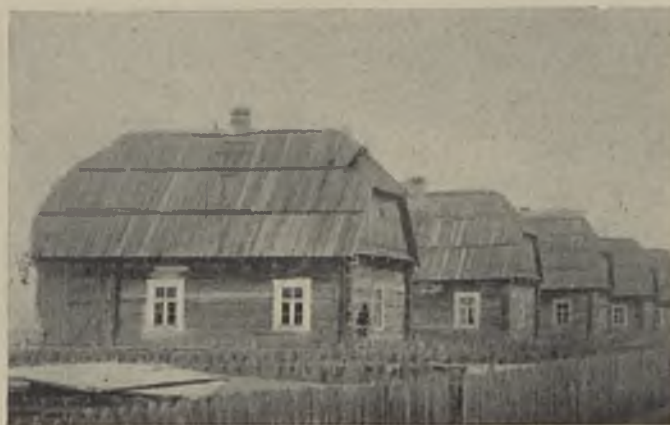
U góry: ogólny widok fabryki; u dołu: domki robotnicze zbudowane w r. 1928
