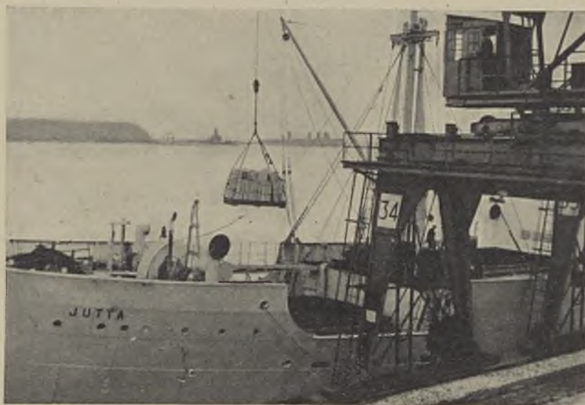
(3) Wyładunek korka przy pomocy dźwigu portowego oraz platformy (planki) zawieszanej na haku dźwigu. Hive znajduje się w powietrzu
