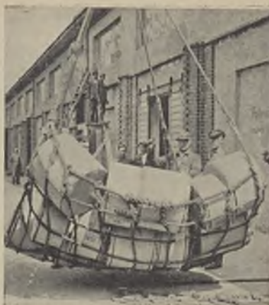
(2) Zdjęcie przedstawia wyładunek papieru ze statku przy pomocy dźwigu portowego. Ładunek umieszczony jest w siatce zawieszanej na haku dźwigu
