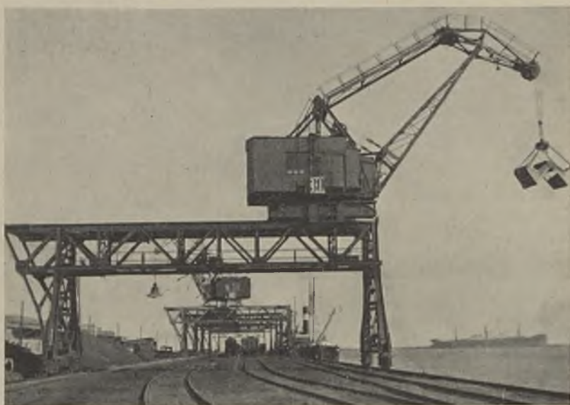
(11) Dźwig portowy z chwytakiem, używany do wyładunku i załadunku węgla, fosforytów, pirytów, rudy itp.
