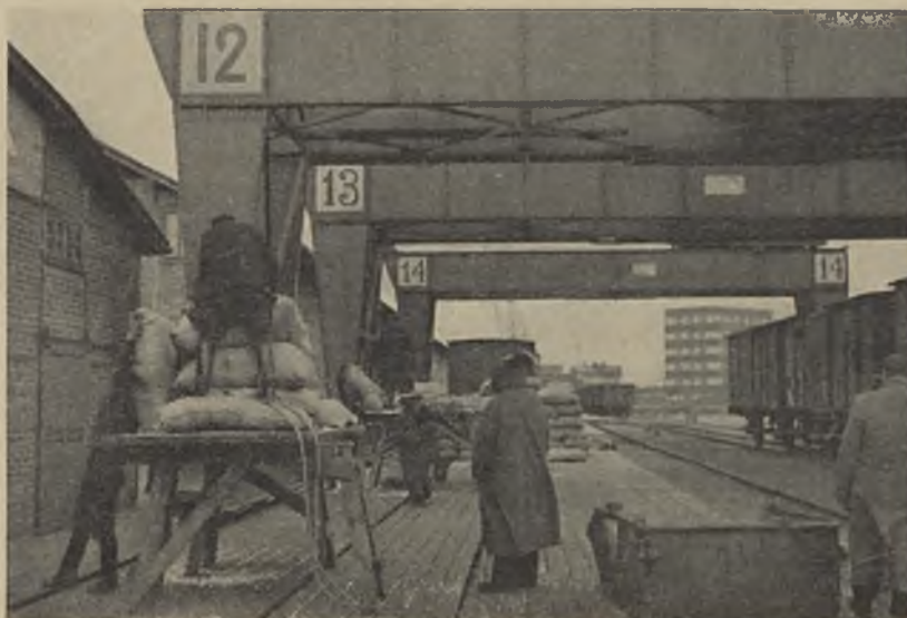
(8) Wyladunek towarów w workach przy pomocy lin (sztropów) i kozłów (szteleży) w chwili, gdy hive został zdjęty z haku dźwigu, a robotnicy na koźle podają innym worki na plecy
